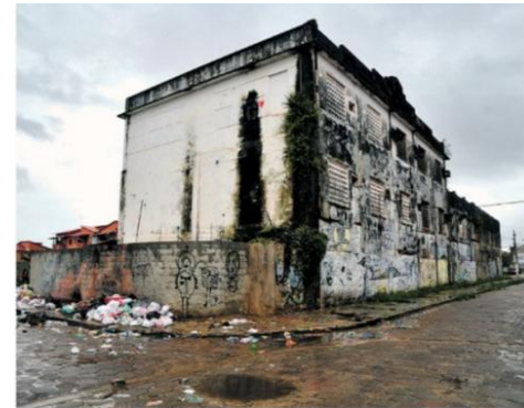
Na rua Professor Nelson Ribeiro, há prédios abandonados e lixo nas ruas MAURO ÂNGELO
