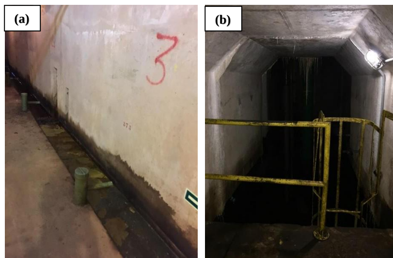
Fotografia 3- Drenos de fundação (a) e galeria de drenagem (b).
